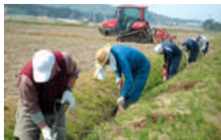
水路の泥上げ
