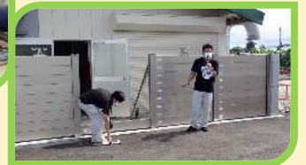
新設された 防水壁↓
